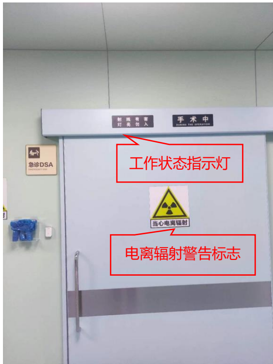
急诊科 DSA 机房工作状态指示灯、 电离辐射警告标志
