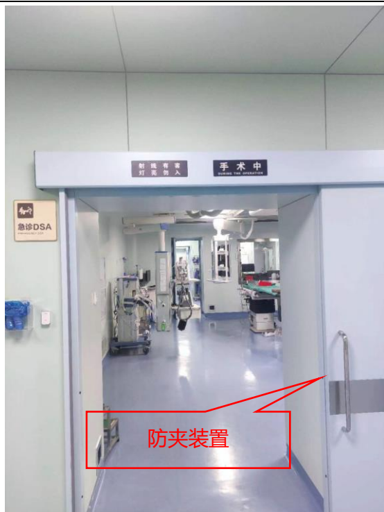
急诊科 DSA 机房防夹装置
