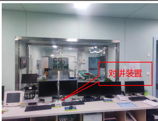
急诊科 DSA 机房观察窗、对讲装置
