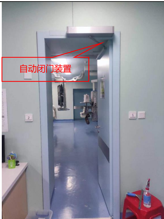
急诊科 DSA 机房自动闭门装置
