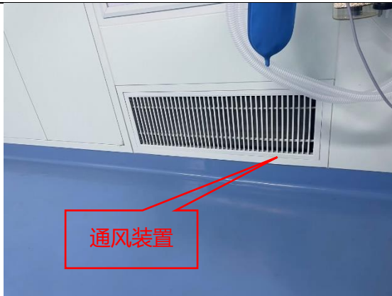
急诊科 DSA 机房通风装置
